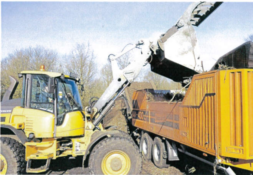
Der Bagger kippt Schaufel für Schaufel in den großen Häcksler der Entsorgungsgesellschaft.
